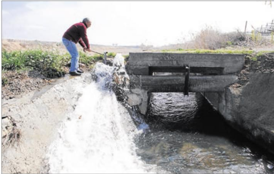
Un regant aixeca una de les pales del canal d'Urgell a l'altura de Vila-sana.
